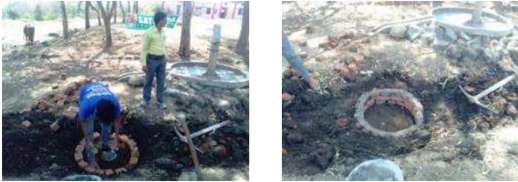
Thuyepani –Volunteers dig a soak pit
